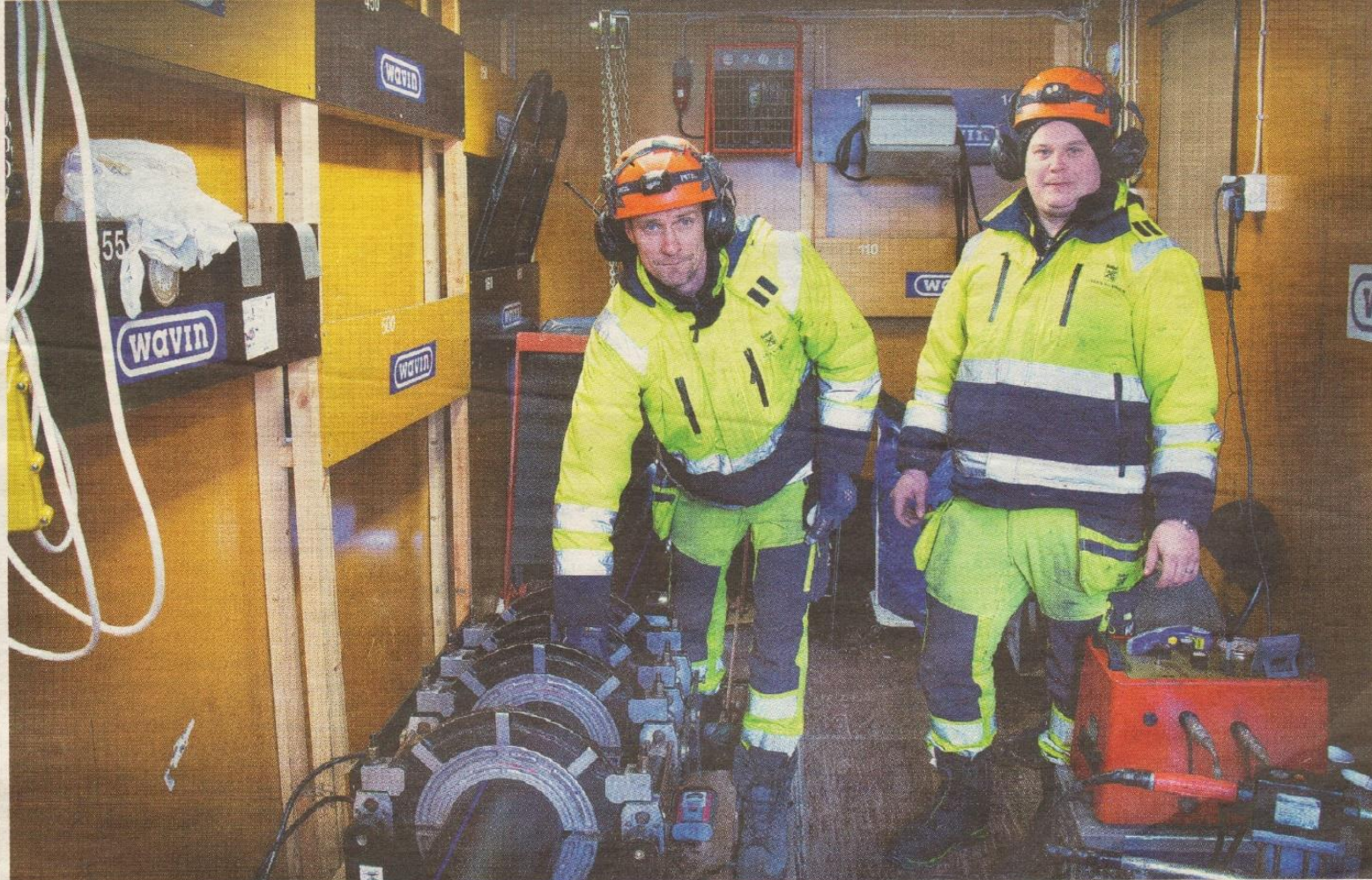
Det rör på sig. Magnus Johansson och Marcus Andersson, anläggningsarbetare, jobbar med dricksvattenledningen till Råneå. 2028 ska den vara klar.
